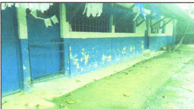
Foto 3: PINTURA DE EN MUROS INTERIORES DE LA ESCUELA
