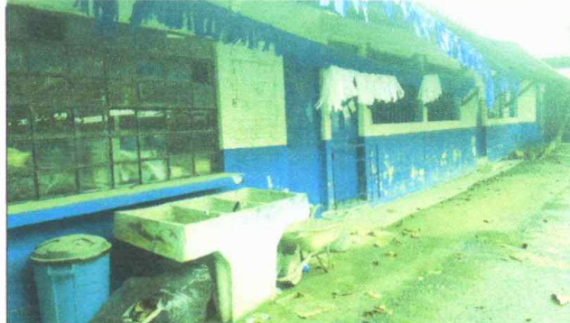
Foto 4: INSTALACION DE PILA TUBERIA DE AGUA POTABLE Y DRENAJE PARA LA PILA
