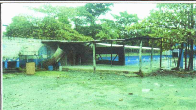
Foto 1: CAMBIO DE ESTRUCTURA DE MADERA POR METAL Y CAMBIO DE LAMINA TROQUELADA CALIBRE 26
