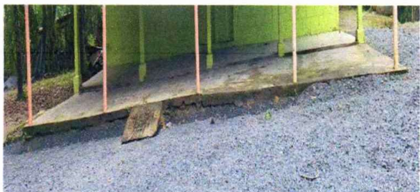
Foto 1: Sustrucción de piso de concreto.
