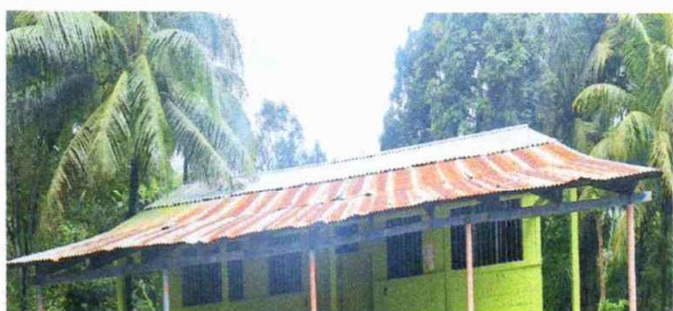
Foto 3: Sustrucción de lámina del corredor.
