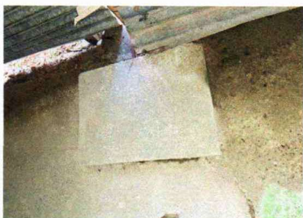
Foto 5: Mantenimiento de fosa séptica.
