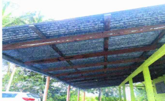
Foto 2: Sustrucción de estructura de madera.
