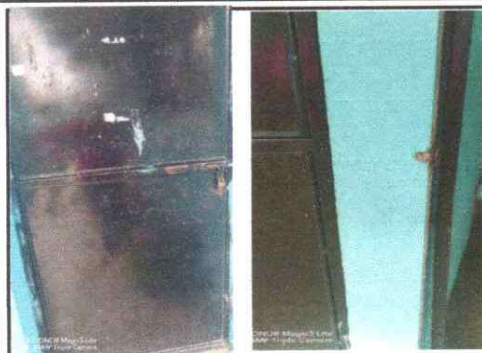
Foto1: Reparación de 10 puertas de metal, lijado, cepillado y pintado.
