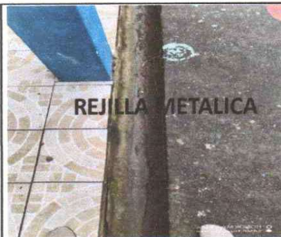
40mts2 de rejilla linial de angular de 1p. Y varilla de 1/2
