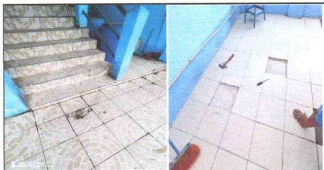
Foto 5: Reparación de piso antiderrisante y cerámico 31 mts en total
