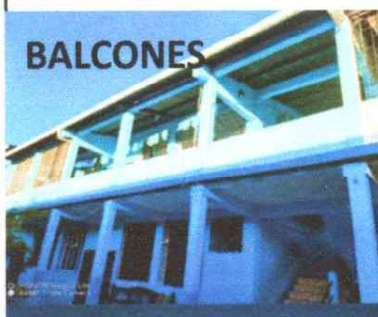
Foto 4: 3 balcones para seguridad del segundo nivel de 6.5mts2 c/u 19.5 en total
