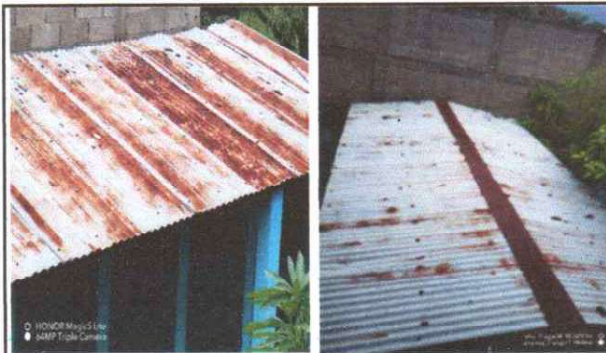
Foto 2: Cambio de lamina de lamina, extensión de estructura metalica de 2.30mts2 , 10 laminas de 10 pies troquelada
