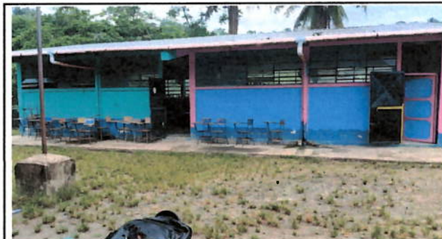
Foto 6: PINTURA EN INTERIORES Y EXTERIORES
