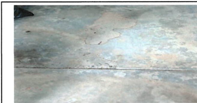
Foto 3: SUSTITUCION DE PISO CERAMICO
