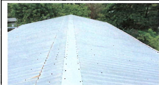
Foto 1: MANTENIMIENTO A LAMINA TROQUELADA
