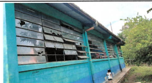
Foto 4: SUSTITUCION DE BALCONES
