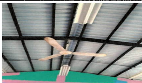
Foto 2: MANTENIMIENTO A ESTRUCTURA DE SOPORTE DE METAL
