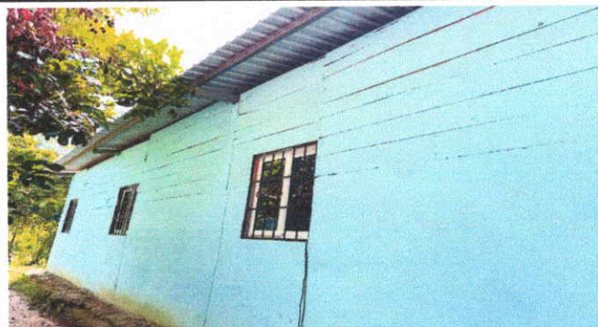
Foto 8: 8. Pintura en muros esteroides e interiores de aula de pre- primaria.
