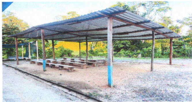
Foto1: 1. Sustitución de lamina troquelada calibre 26 de alucin
