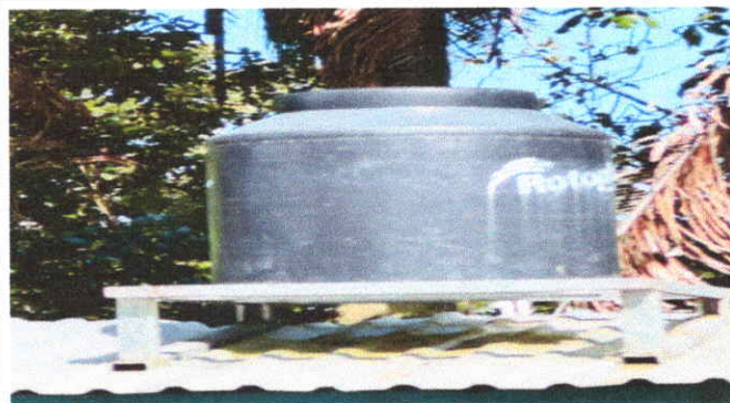
Foto 10: 10. Sustitución de depósito de agua .
