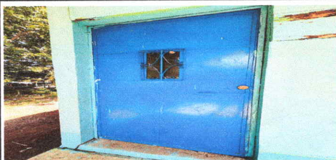
Foto 3: 3. Mantenimiento a puertas de aula de pre- primaria ( raspado lijado y aplicación de pintura ) .
