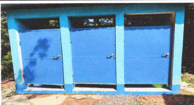
Foto 9: 9. Mantenimiento a estructura de metal de servicios sanitarios ( pasmado lijado, y aplicación de pintura).
