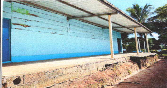
Foto 4: 4. Sustitución de balcones de metal
