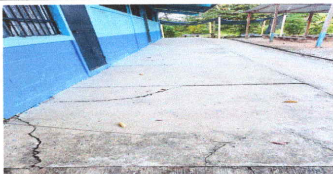
Foto 7: 7. Sustitución de piso cerámico antideslizante en corredor frente a aula de primaria.
