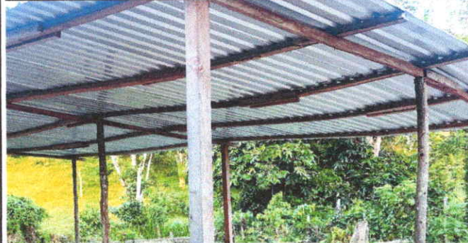
Foto 2: 2. Sustitucion de soporte de madera por Metal
