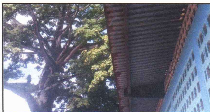
Foto 5: Láminas del salón de usos múltiples en malas condiciones.
