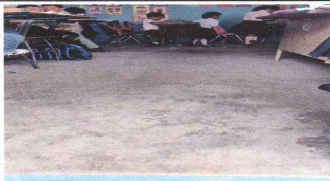
Foto1: SUSTITUCIÓN DE PISO DE GRANITO EN AULA
