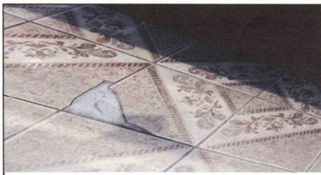
Foto 4: SUSTITUCIÓN DE PISO CERÁMICO EN DIRECCIÓN
