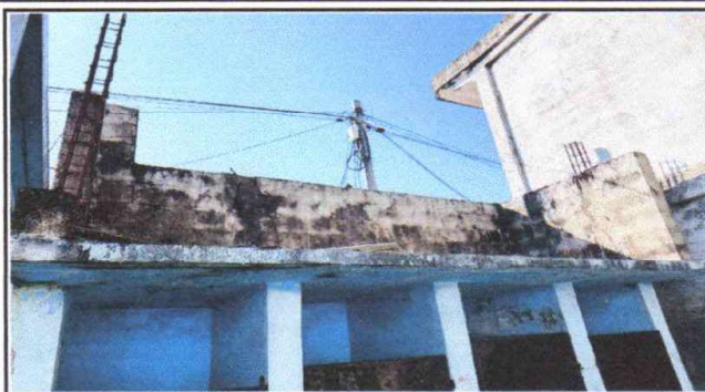
Foto 2: SUSTITUCIÓN DE DEPOSITO DE AGUA
