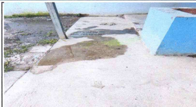
Foto 2: SUSTITUCION DE PISO DE TORTA EN AREA DE BAÑOS
