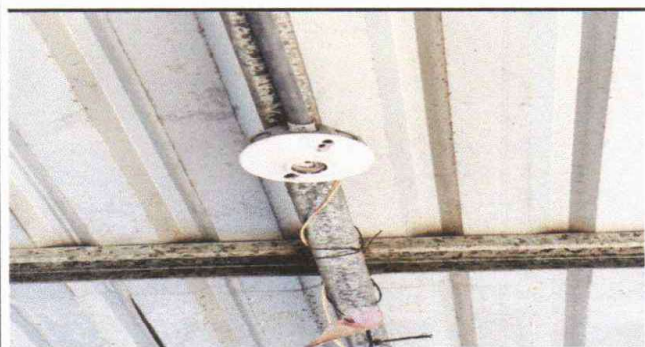
Foto 3: REPARACIÓN DE CABLEADO ELÉCTRICO
