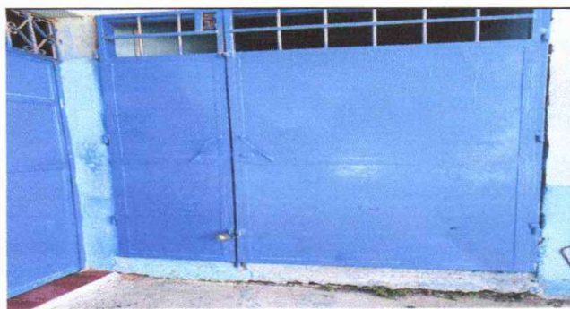
Foto 6: SUSTITUCIÓN DE PUERTAS EN COCINA
