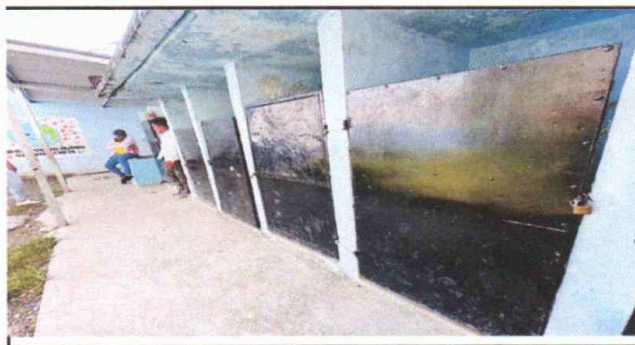
Foto 6: SUSTITUCIÓN DE PUERTAS EN SERVICIOS SANITARIOS
