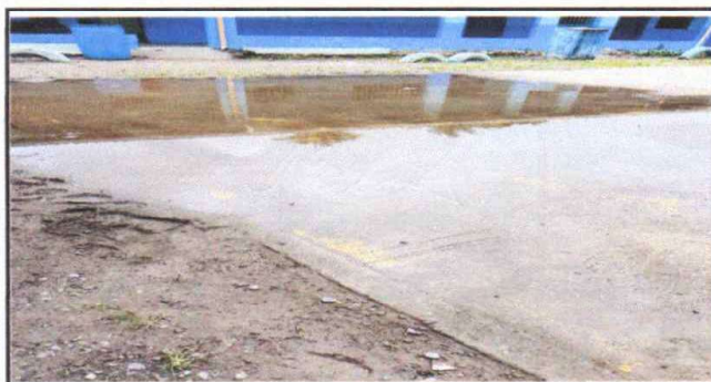
Foto 5: REPARACIÓN DE CUNETETA AREA VERTICAL
