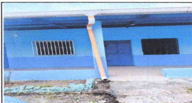
Foto 3: REPARACIÓN DE CUNETETA AREA FRONTAL
