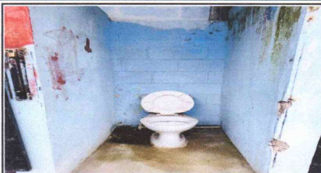
Foto1: SUSTITUCIÓN DE 6 INODOROS
