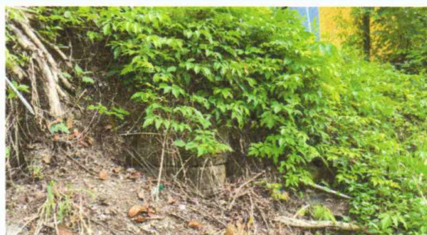
REPARACION DE MURO DE CONTENCION
