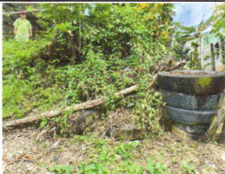
REPARACION DE MURO DE CONTENCION
