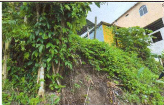
REPARACION DE MURO DE CONTENCION
