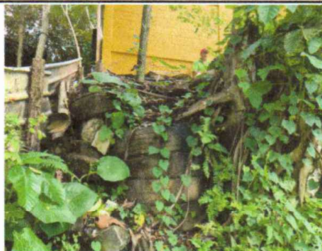
REPARACION DE MURO DE CONTENCION
