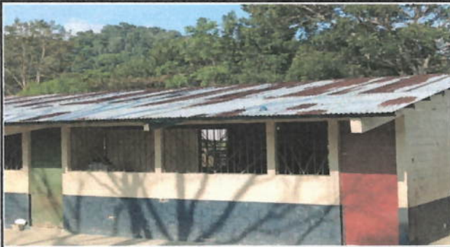
Foto 1: cambio de techo.
