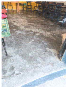
Foto 3: SUSTITUCION DE PISO DE CONCRETO A CERAMICO
