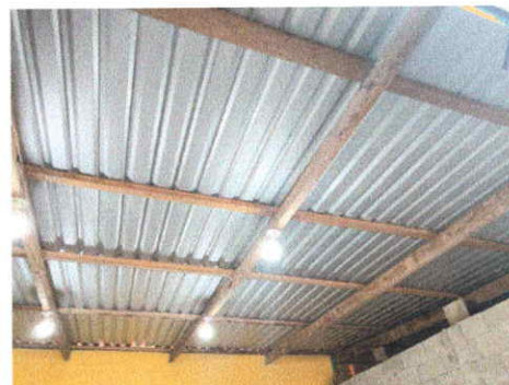
Foto 4: SUSTITUCION DE ESTRUCTURA DE SOPORTE DE MADERA, POR METAL
