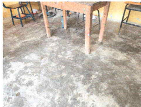
Foto 4: SUSTITUCION DE PISO DE CONCRETO A CERAMICO
