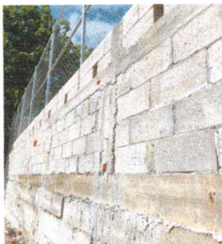
Foto 1: Colocación de tres tensores para mejorar el soporte del muro de contención.
