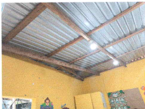
Foto 3: SUSTITUCION DE ESTRUCTURA DE SOPORTE DE MADERA, POR METAL
