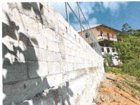
Foto 2: Colocación de tres tensores para mejorar el soporte del muro de contención.
