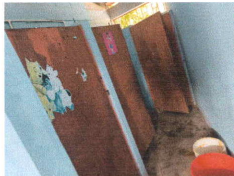
Foto 2: SUSTITUCION DE PUERTA EN SERVICIOS SANITARIOS
