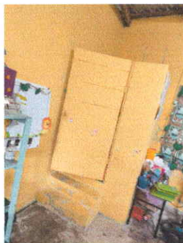
Foto 1: SUSTITUCION DE PUERTA EN SERVICIOS SANITARIOS
