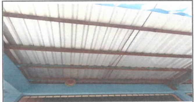
Foto 2: SUSTITUCION DE CAMIBO DE COSTANERAS
