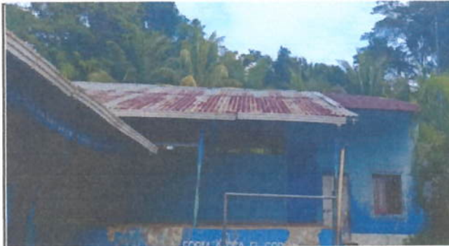
FOTO NO. 1 SUSTITUCION DE LAMINA DE ALUCIN
