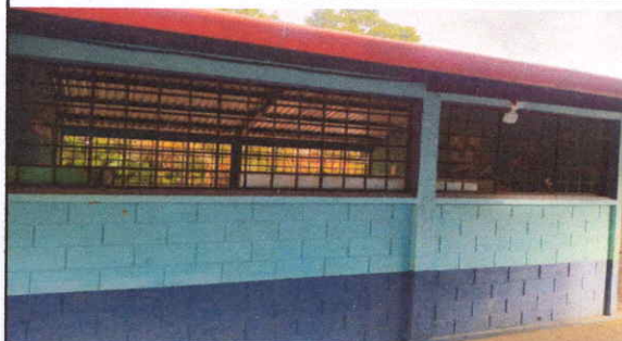
Foto 4: pintura en muros exteriores e interiores en aulas
