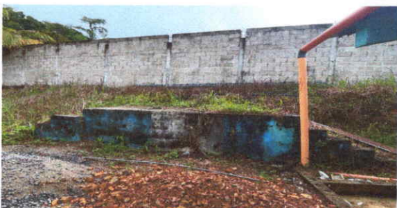
foto 5: reparacion de torta de concreto
