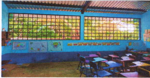
Foto1: sustitucion de ventana de metal por metal mas vidrio 1.15 de largo por 4.00 de ancho
