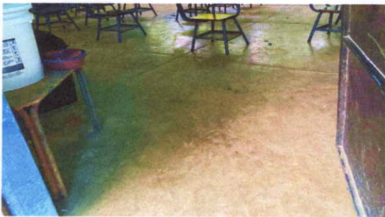
Foto 3: sustitucion de piso ceramico
