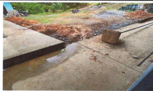
Foto 2: sustitucion de piso de torta por concreto de banquetta
