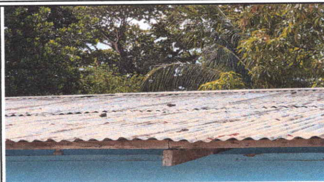
Foto 2: Techo en Sustitución
