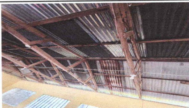
Foto1: Techo en Sustitución
