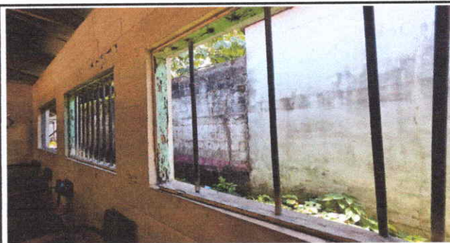
Foto 4: Mantenimiento de balcones
