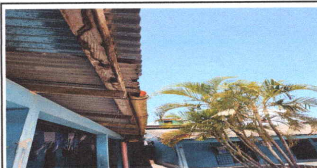
Foto 6: Canal en Sustitución
