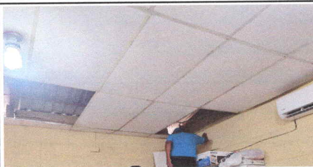
Foto 3: Cielo falso en Sustitución
