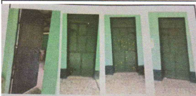
sustitucion de 4 puertas
