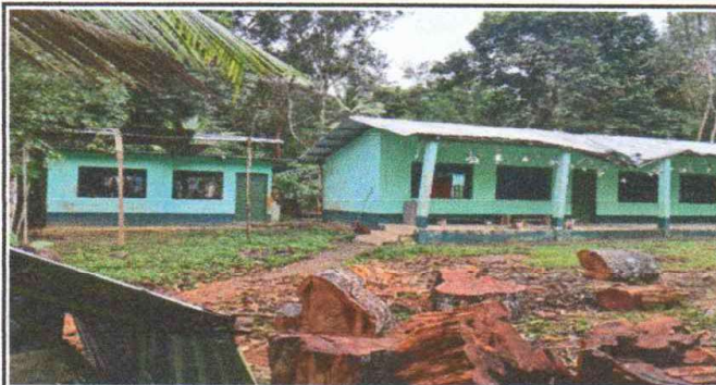
sustitucion de lamina por lamina de aluzin calibre 26, sustitucion de estructura de madera por metal.
