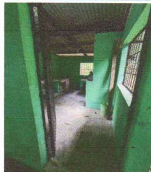
Puesta de piso ceramico antideslizante cocina.
