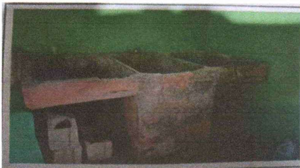
foto 1: sustitucion de l pila de concreto por plastica
