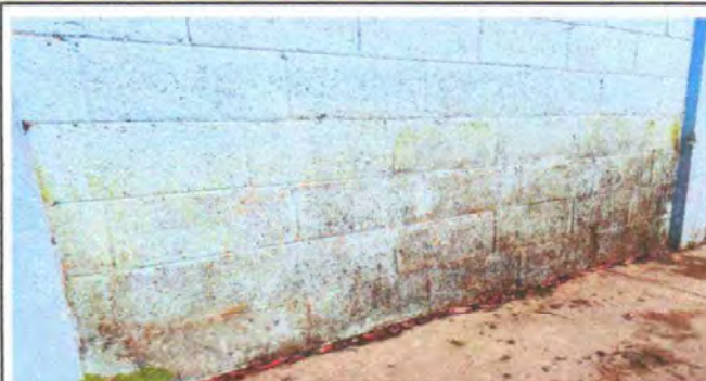
Foto 16: Descripción 9 Pintura en muros exteriores e interiores, 9.1 Pintura en muros exteriores e interiores
