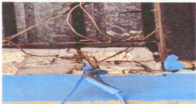
Foto 7: Descripción 17: Reparación del sistema eléctrico, 17.11 Reparación de cableado eléctrico
