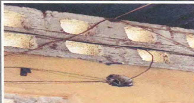
Foto 9: Descripción 17: Reparación del sistema Eléctrico 17.11 Reparación de cableado eléctrico
