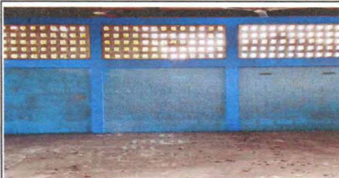
Foto 15: Descripción 9 Pintura en muros exteriores e interiores, 9.1 Pintura en muros exteriores e interiores
