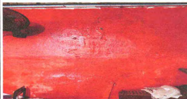
Foto 14: Descripción 21 Reparación de repello y cernido de paredes, 21.1 repello en muro
