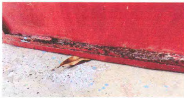
Foto1: Descripción 4: Puerta de metal 4.1 Mantenimiento a estructura (lijado, cambio de tubo, aplicación de pintura)
