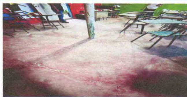
Foto 4: Descripción 6: Piso 6.5 Sustitución de piso de torta de concreto
