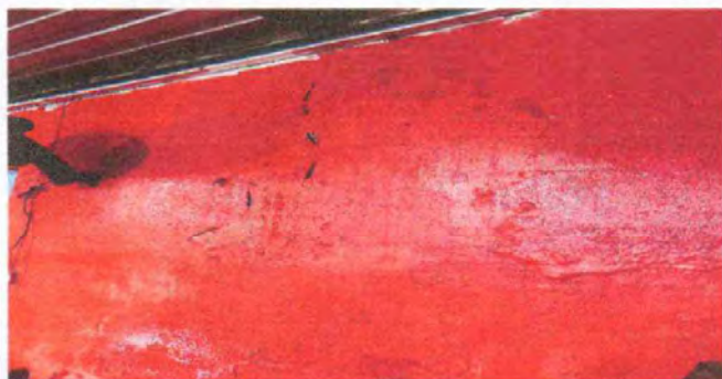
Foto 13: Descripción 21 Reparación de repello y cernido de paredes, 21.1 repello en muro
