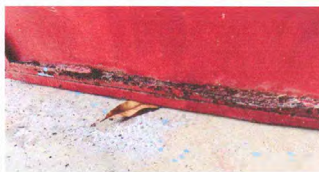
Foto2: Descripción 4: Puerta de metal 4.1 Mantenimiento a estructura (lijado, cambio de tubo, aplicación de pintura)
