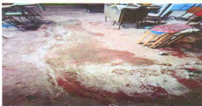
Foto 3: Descripción 6: Piso 6.5 Sustitución de piso de torta de concreto
