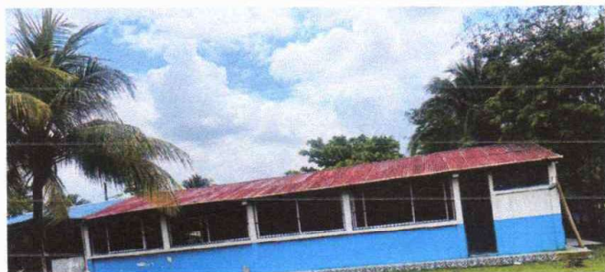
Foto 5: MANTENIMIENTO DE LA ESTRUCTURA
