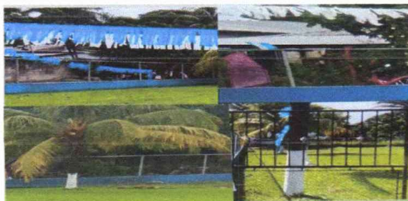
Foto 4: PINTURA EN MUROS EXTERIORES E INTERIORES.
