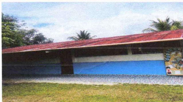
Foto1: Sustitución de techo.
