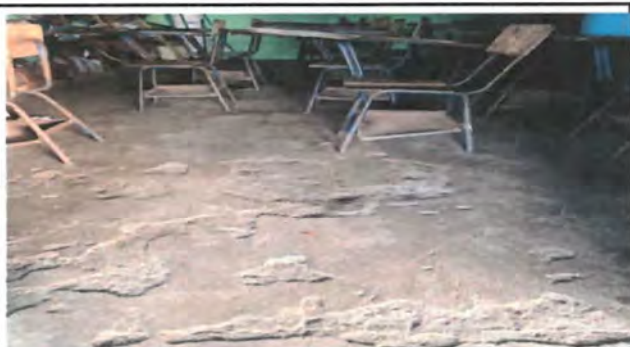
SUSTITUCION DE PISO DE TORTA DE CONCRETO
