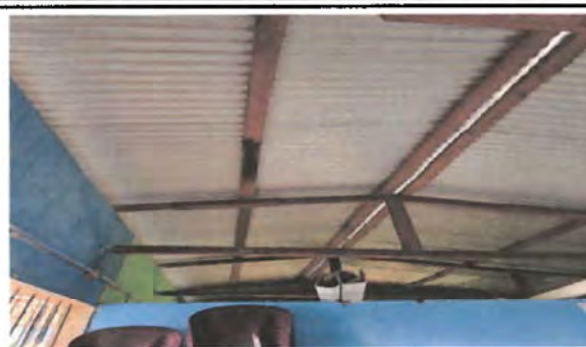
SUSTITUCION DE ESTRUCTURA DE SOPORTE DE MADERA, POR METAL
