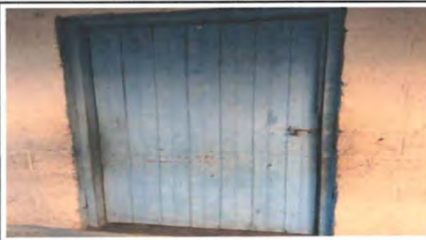
SUSTITUCION DE PUERTA
