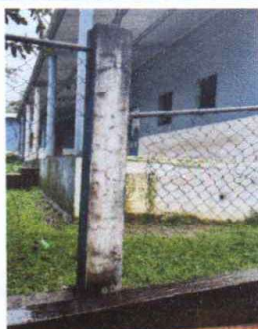
Foto1: Reparación de muro perimetral
