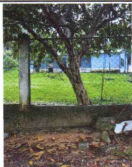
Foto 3: Reparación de muro perimetral
