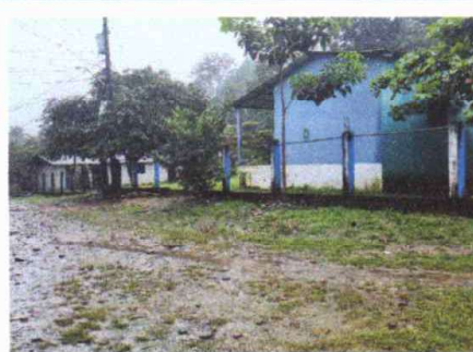
Foto 2: Reparación de muro perimetral
