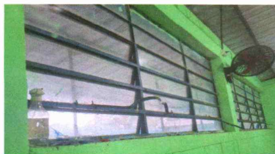
Foto 4: Sustitución de balcones en mal estado.
