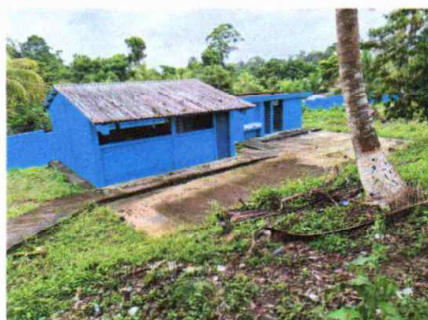
Foto 2: Reparación de piso de concreto.
