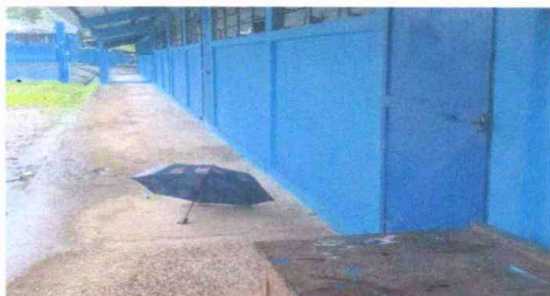
Foto 3: Sustitución de piso cerámico.
