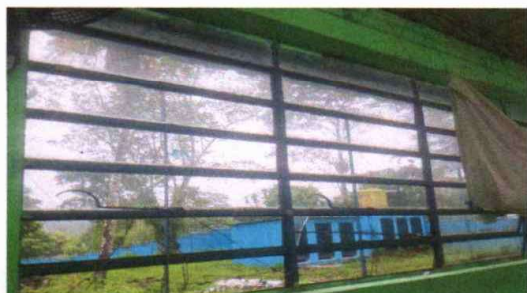
Foto 1: Mantenimiento de balcones.
