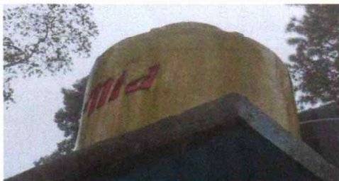
Foto 7: Mantenimiento de tanque de agua potable.
