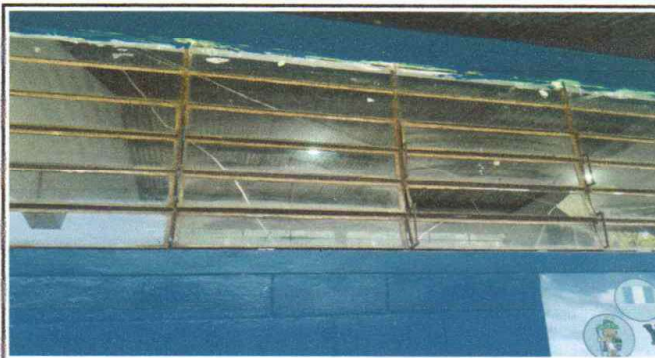
SUSTITUCION DE VENTANAS DE METAL POR BALCONES
