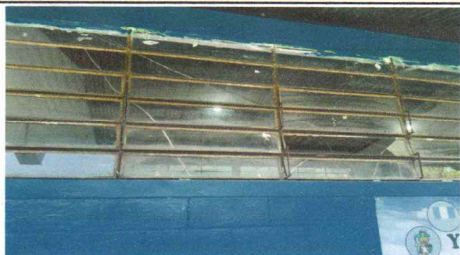
SUSTITUCION DE VENTANAS DE METAL POR BALCONES
