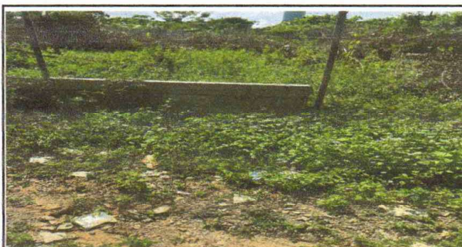
REPARACION DE MURO PERIMETRAL
