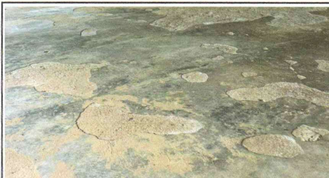
SUSTITUCION DE PISO LIQUIDO EN MODULOS DE AULAS PO CERAMICO
