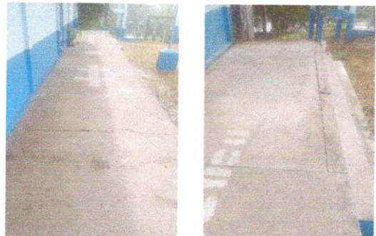
Foto 4: 6.2 Sustitución de piso de torta de concreto por piso cerámico antideslizante
