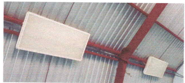
Foto 6: 16.3 Sustitución de lamparas tipo LED
