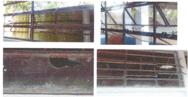
Foto 2: 5.1 Mantenimiento a estructura de metal de ventana
