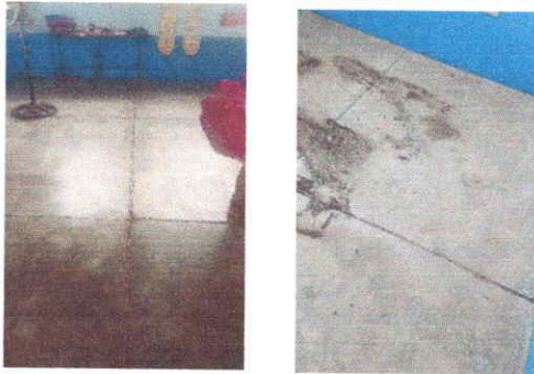
Foto 3: 6.1 Sustitución de piso de torta de concreto por piso cerámico lizo
