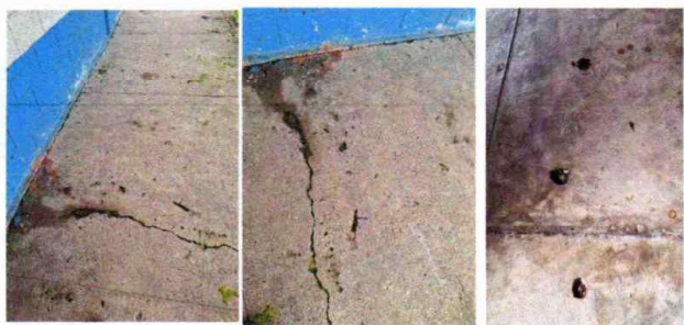
Foto1: Sustitución de piso en aulas y corredor.
