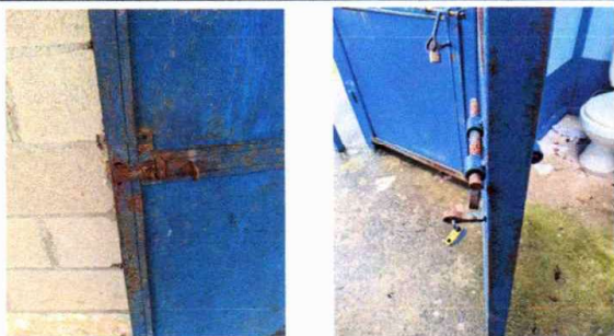
Foto 5: Mantenimiento de puertas de metal.
