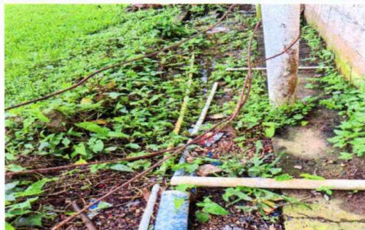
Foto 3: Sustitución de tubería de aguas negras.
