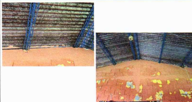
Foto 2: Sustitución de lámina.
