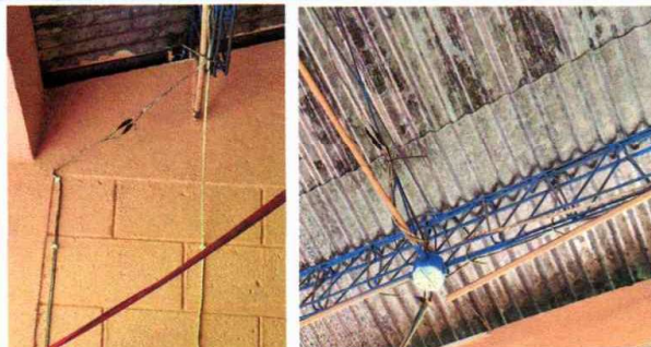
Foto 6: Reparación de cableado eléctrico.
