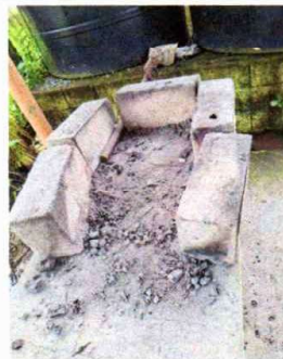
Foto 4: Sustitución de Chimenea.
