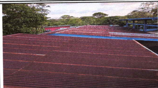
Foto 1: sustitución de lámina
