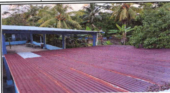
Foto 2: sustitución de lámina
