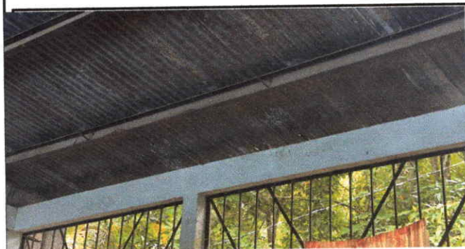
Foto 3: sustitución de lámina
