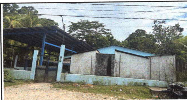
Foto 6: reparación de muro
