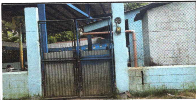
Foto 5: mantenimiento a portones
