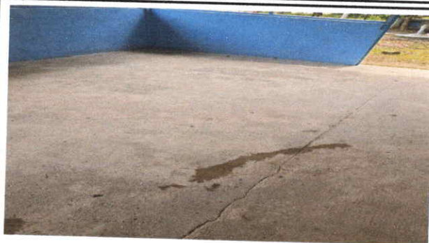
Foto1:sustitución de piso ceramico
