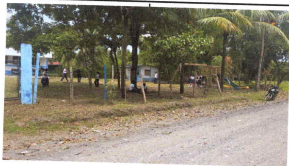
Foto 3: Reparacion de block con tubo hg y malla galvanizada lado izquierdo
