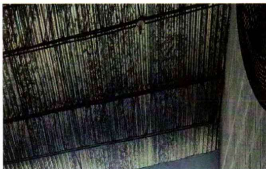
Foto 2: Sustitución de estructura de metal por metal
