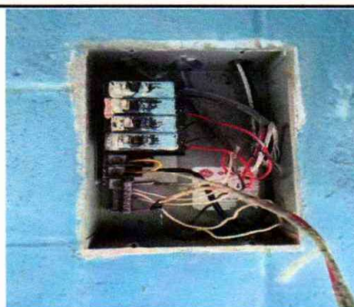
Foto 6: sustitución del sistema electrico
