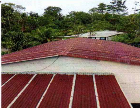
Foto1: Sustitución de lámina por lamina troquelada de aluzin calibre26
