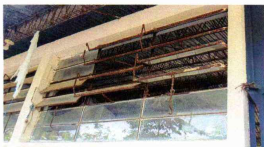
Foto 5: Mantenimiento a balcones de metal
