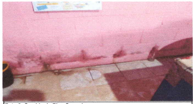
Foto 6: Cambio de Piso Cerámico
