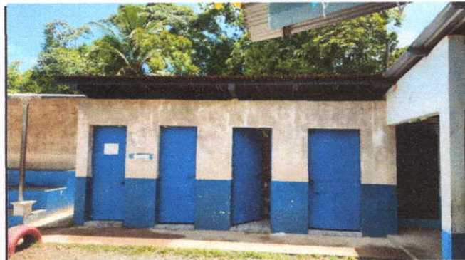
Foto 3: Cambio de techado. Estructura metálica levantamiento de piso y colocación de cerámico. Cambio de inodoro.
