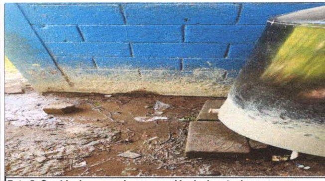
Foto 5: Cambio de accesorio y reparación de rotomolas para agua potable
