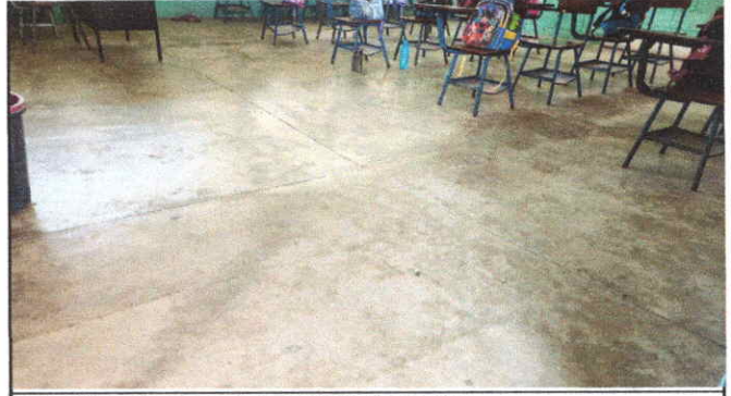
Foto 2: levantamiento de piso y torta de concreto
