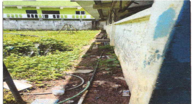
Foto 4: Cambio de tubería de agua potable
