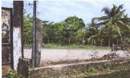
Foto 6: REPELLO DE HILADAS DE BLOCK
