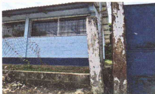
Foto 4: MALLA EN MAL ESTADO AFECTA PORQUE ESTA ORILLA DE CALLE PRINCIPAL
