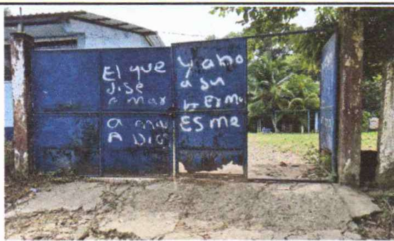
Foto 2: REMOZAMIENTO DE PORTON DE ENTRADA AL ESTABLECIMIENTO
