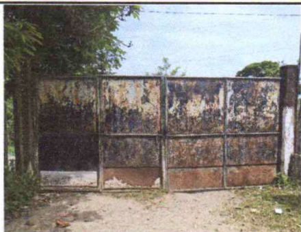
Foto 1: REMOZAMIENTO DE PORTON DE ENTRADA AL ESTABLECIMIENTO
