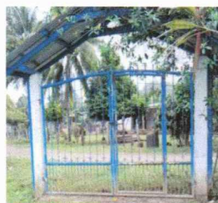
Foto 4: Barandas de metal y portón oxidados y en mal estado.
