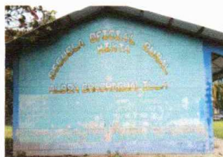
Foto 1: Pintura en muros exteriores e interiores en mal estado.
