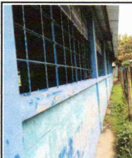
Foto 1: Pintura en muros exteriores e interiores en mal estado.
