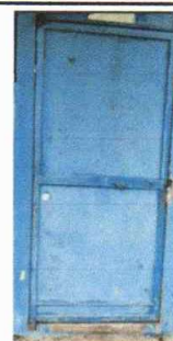
Foto 2: Mal estado de las puertas servicios sanitarios, tienen oxido y necesitan ser pintadas.
