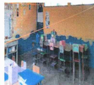
Foto 6: El piso de las aulas no tienen cerámico, son de torta de cemento.
