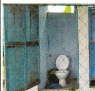
Foto 3: Sanitario que no se pueden utilizar y de fosa septica que necesita limpieza.
