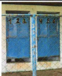
Foto 2: Mal estado de las puertas servicios sanitarios, tienen oxido y necesitan ser pintadas.
