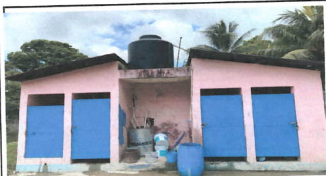
Foto 3: Reparación de Tubería de tanque de agua.
