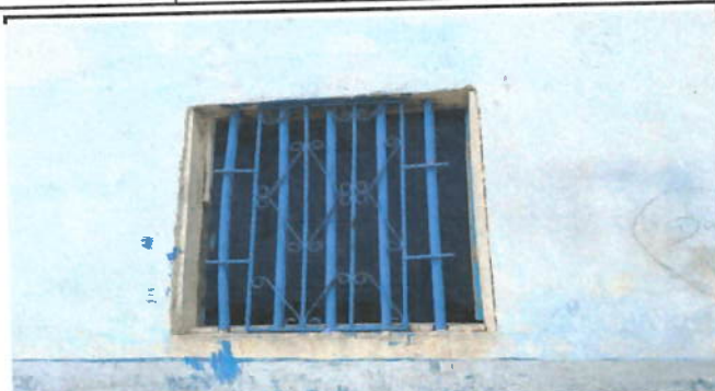
Foto 2: Reparación de Balcones en mal estado
