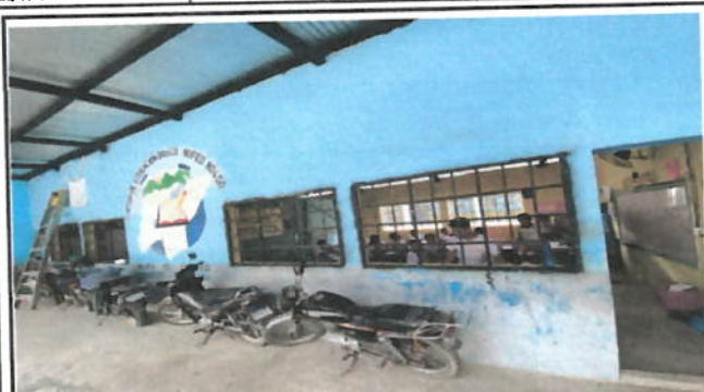
Foto1: Reparacion de aerea de corredor
