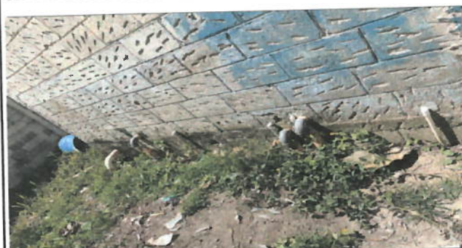
Foto 5: Reparacion de Tuberia de drenaje
