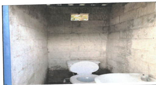
Foto 6: Repello de pared de sanitario.
