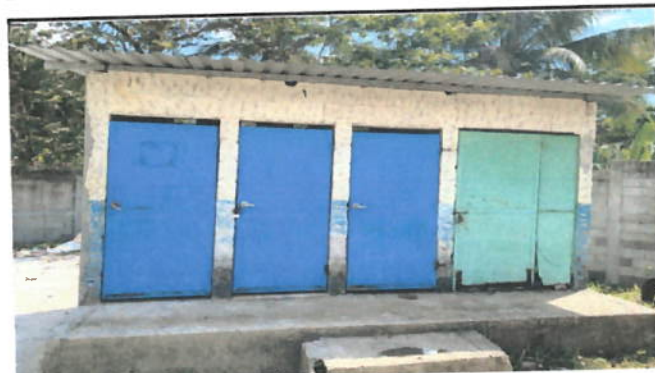
Foto 4: Reparación de Sanitarios
