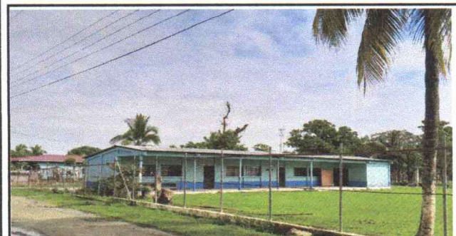
Foto 5: Pintura en muro exteriores e interiores
