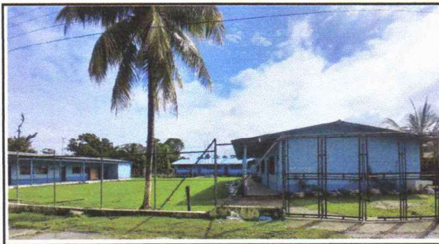
Foto 4: Área del muro perimetral que necesita ser reparado
