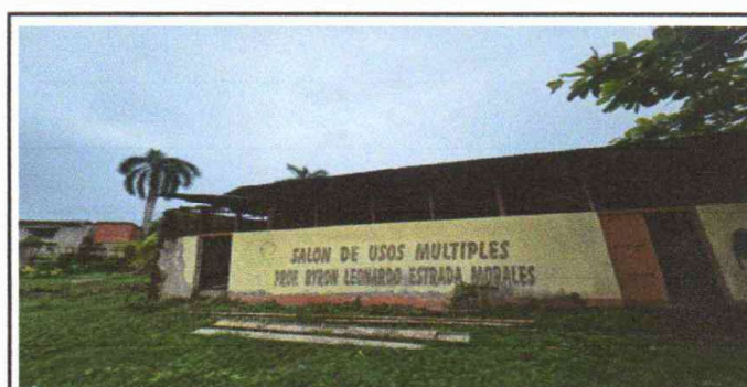
VISTA DE PUERTAS
