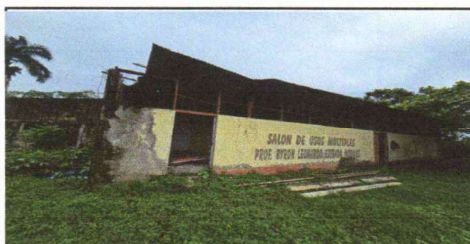
VISTA DE PUERTAS
