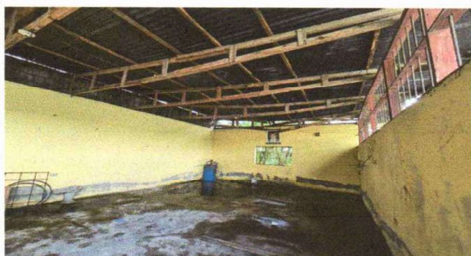
TECHADO Y PISO DE SALON DE ACTOS
