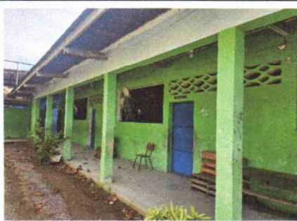
Foto 2: SUSTITUCIÓN DE PINTURA EN MUROS EXTERNOS
