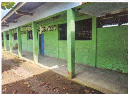
Foto1: SUSTITUCIÓN DE PINTURA EN MUROS EXTERNOS
