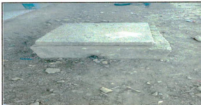
FOTO NO.5 Rejillas del drenaje en mal estado
