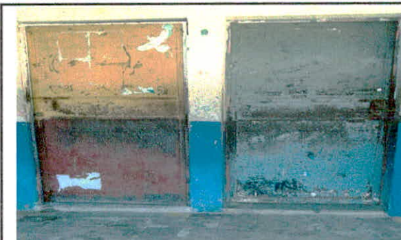
FOTO NO.6 Puertas de 7 aulas en mal estado, oxidadas y otras podridas
