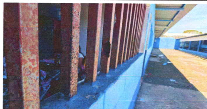
Foto 2: Mantenimiento de Balcones.
