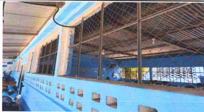
Foto 1: Mantenimiento de Balcones.
