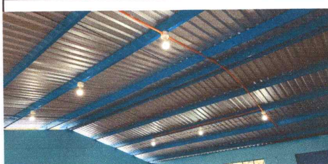
Foto 2: Nueva instalacion de Cabiado Eléctrico
