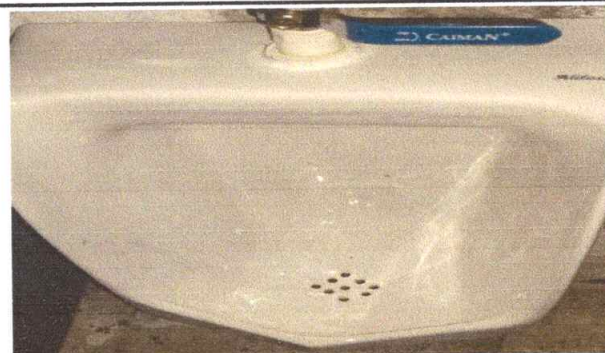
Foto 4: Sustrucion de Mingitorio
