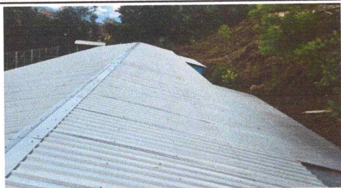
Foto 1: Sustrucción de Laminas
