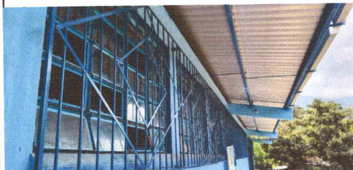
Foto 3: Sustrucciones de Balcones de Metal
