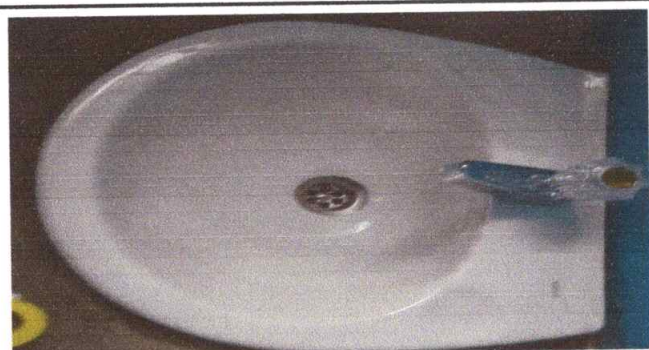
Foto 5: Instalacion de lavamanos
