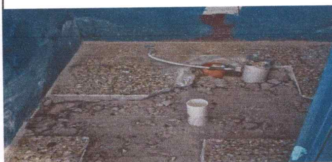
Foto 6: Sustitución de inodoro
