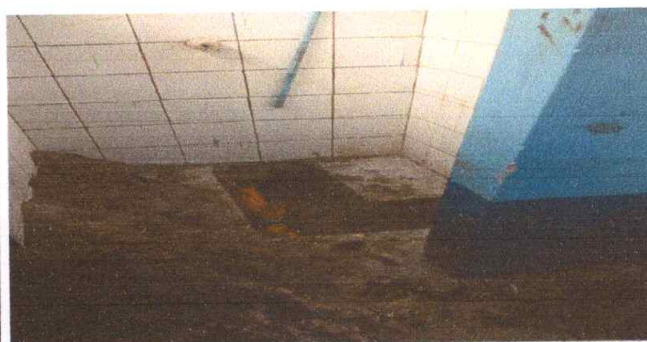
Foto 4: Sustitucion de Mingitorio
