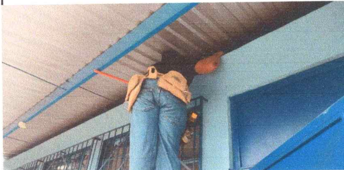
Foto 2: Reparación de Cabiado Eléctrico
