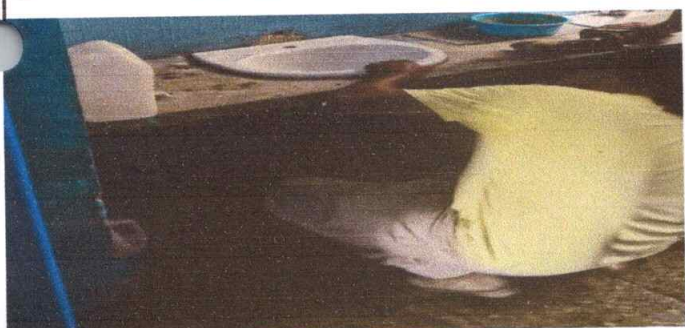
Foto 5: Instalacion de lavamanos
