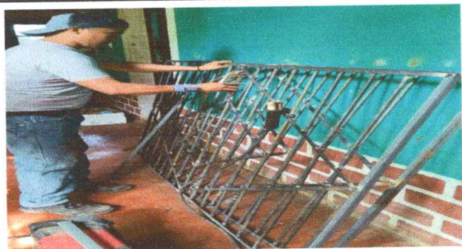
Foto 3: Sustituciones de Balcones de Metal
