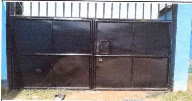
Foto 3: Reparación de portón 360x230
