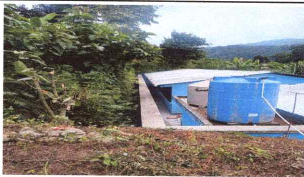
Foto 5: Sustitución de un tinaco por uno de 2,500 litros
