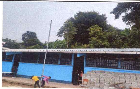
Foto 2: Sustitución de lamina por lamina troquelada
