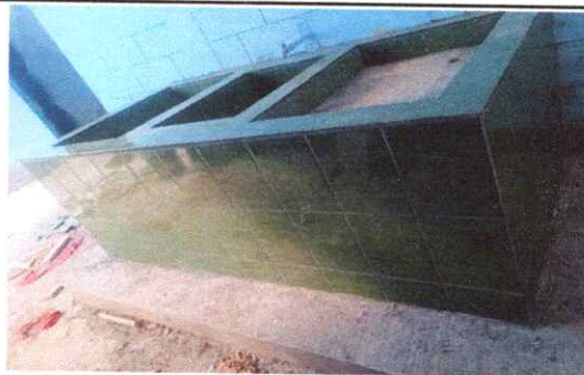
Foto 6: Colocación de azulejos con la pila
