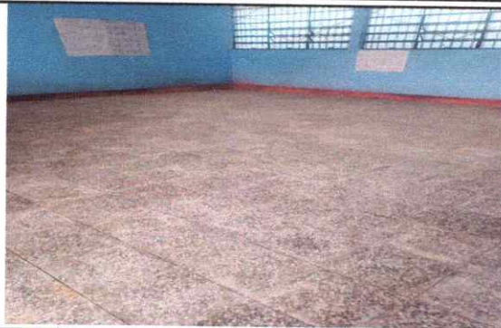
Foto1: Sustitución de piso por piso de granito
