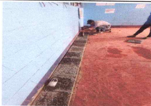
Foto1: Sustitución de piso por piso de granito
