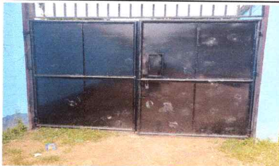
Foto 3: Reparación de portón 360x230
