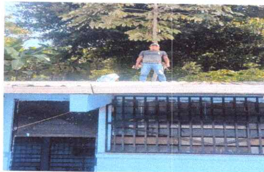
Foto 2: Sustitución de lamina por lamina troquelada
