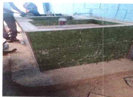
Foto 6: Colocación de azulejos con la pila
