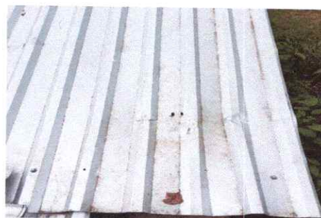
Foto 2: Sustrución de lamina por lamina troquelada
