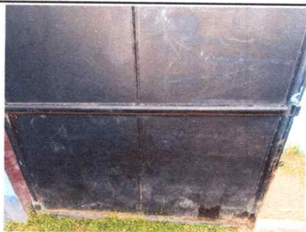
Foto 3: Reparación de portón 360x230
