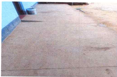
Foto 1: Sustrución de piso por piso de granito
