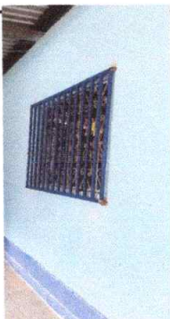
Foto 3: Sustitución de balcones de metal
