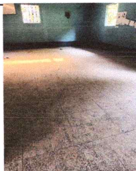
Foto 4: Sustitución de piso granito
