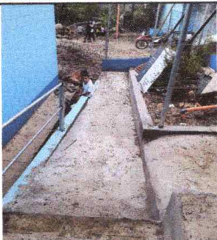
Foto 1: Sustitución de piso de torta de concreto
