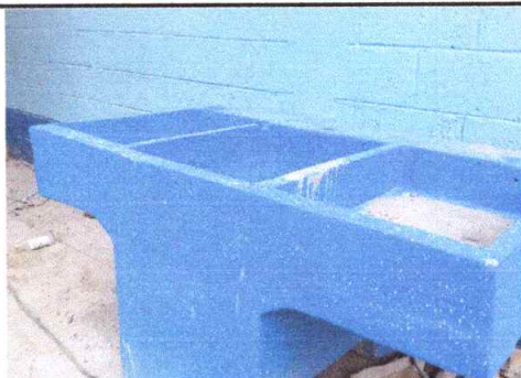
Foto 3: Sustitución de pila portátil de concreto de dos lavaderos
