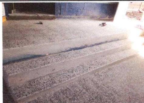
Foto 2: Sustitución de piso de granito en cocina
