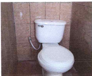
Foto 5: Sustitución de inodoro
