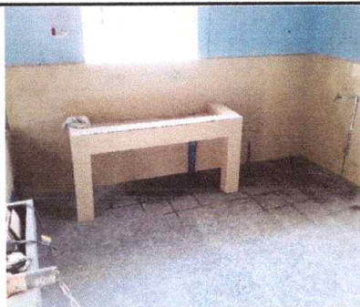
Foto 6: Sustitución de azulejo en muebles de cocina.
