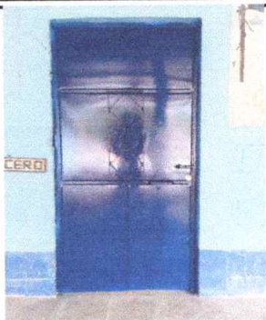
Foto 1: Lijado y pintura de puertas
