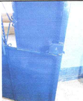
Foto 2: Sustitución de chapas
