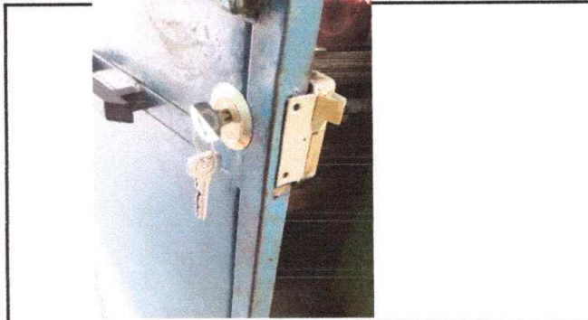
Foto 2: Sustitución de chapas
