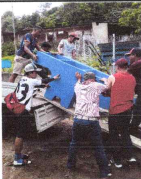
Foto 3: Sustitución de pila portátil de concreto de dos lavaderos
