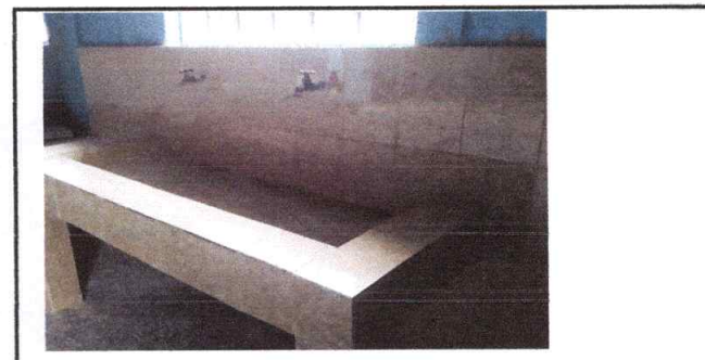
Foto 6: Sustitución de azulejo en muebles de cocina.
