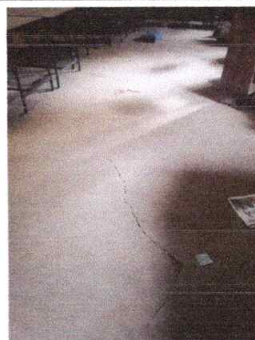
Foto 4: Sustitución de piso granito
