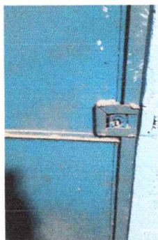
Foto 2: Sustitución de chapas
