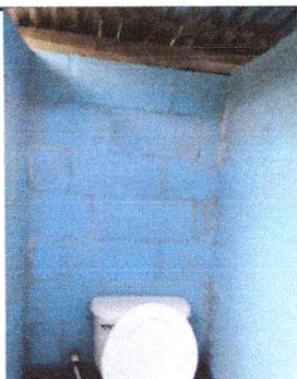
Foto 4: Sustrucción de cerámico en baños
