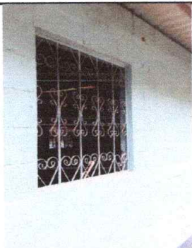
Foto 3: Sustitución de balcones de metal
