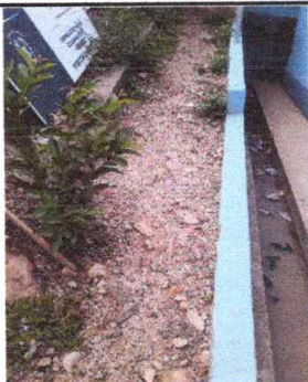
Foto 1: Sustrucción de piso de torta de concreto
