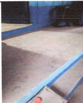
Foto 2: Sustrucción de piso de granito en cocina
