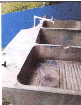
Foto 3: Sustrucción de pila portátil de concreto de dos lavaderos
