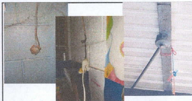
Foto 11: Reparación de sistema eléctrico
