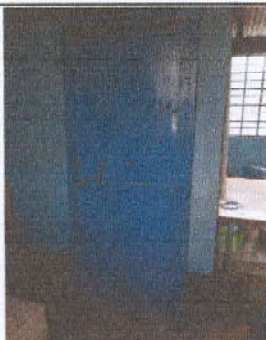
Foto 3: Sustitución de puertas
