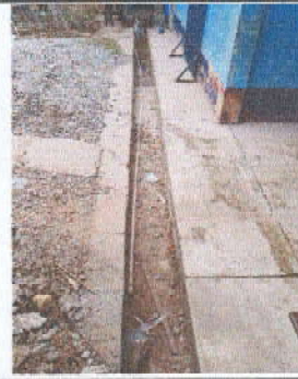
Foto 8: Reparación de red de drenaje
