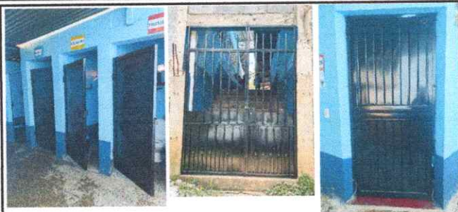
Foto 1: Sustrucción de puertas en servicios sanitarios. Sustrucción de portón de metal. Sustrucción de puerta (2.10m de alto * 0.90m de ancho). Mejoramiento de columna de portón por fisura.
