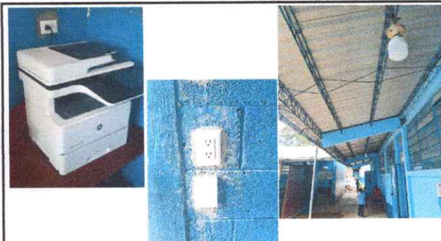
Foto 4: Reparación de sistema eléctrico
