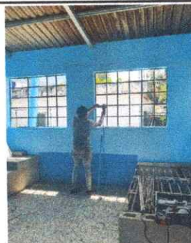
Foto 2: Sustitución de ventanas de madera por metal mas vidrio
