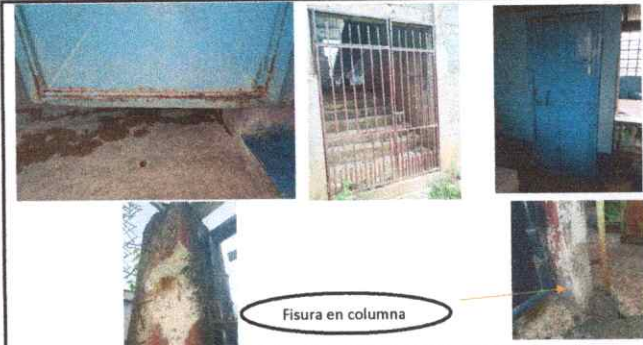
Foto1: Sustitución de puertas en servicios sanitarios. Sustitución de portón de metal. Sustitución de puerta (2.10m de alto * 0.90m de ancho). Mejoramiento de columna de portón por fisura.
