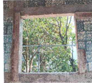
Foto 2: Sustitución de ventanas de madera por metal mas vidrio
