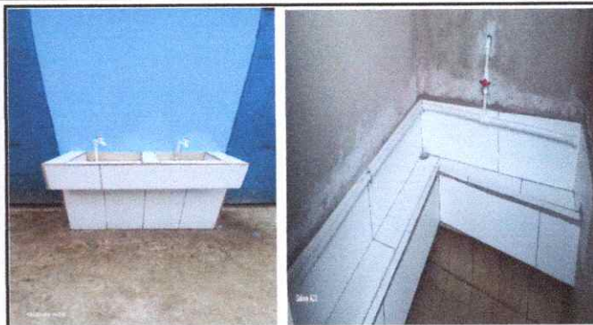
Foto 8: Sustitución de lavamanos y mingitorio.
