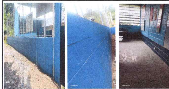
Foto 6: Pintura en muros exteriores e interiores.
