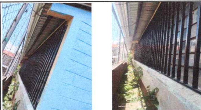
Foto 3: Sustitución de balcones.
