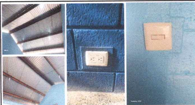
Foto 7: Reparación de sistema eléctrico.
