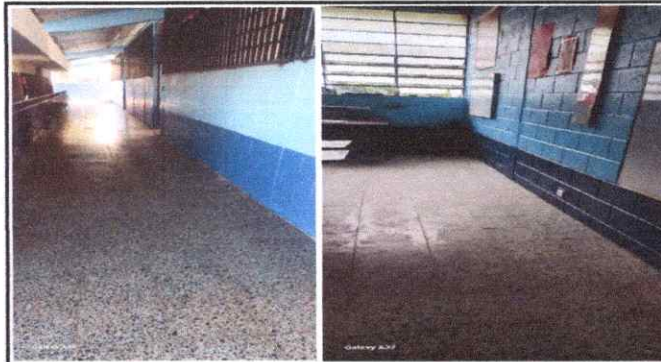
Foto 4: Sustitución de piso de granito.
