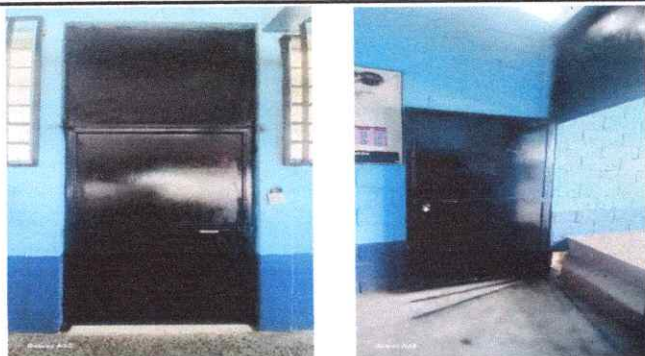
Foto1: Mantenimiento a estructura (lijado, aplicación de pintura).
