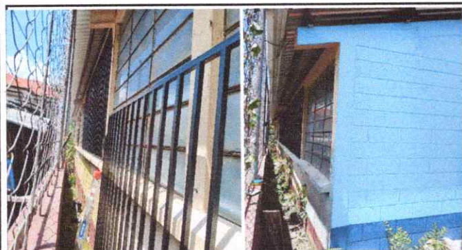
Foto 3: Sustitución de balcones.
