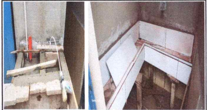
Foto 8: Sustitución de lavamanos y mingitorio.
