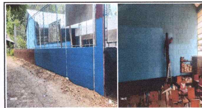
Foto 6: Pintura en muros exteriores e interiores.
