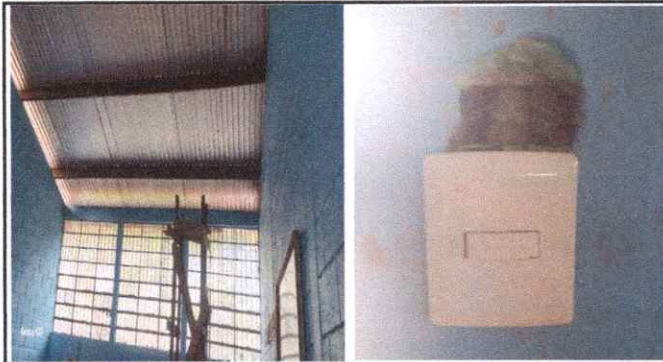
Foto 7: Reparación de sistema eléctrico.
