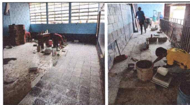
Foto 4: Sustitución de piso de granito.
