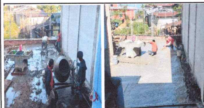
Foto 5: Sustitución de torta de concreto.
