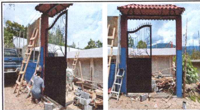
Foto 2: Sustitución de portón de metal con techo incluido.
