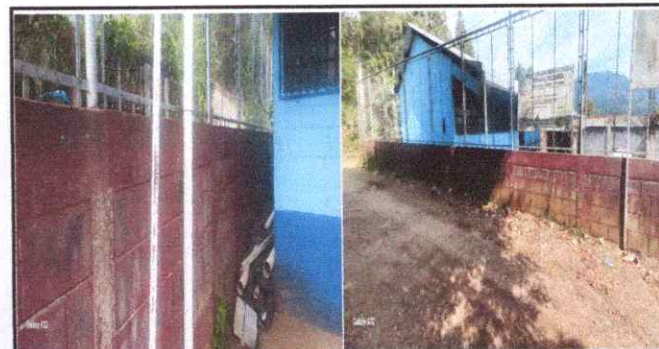
Foto 6: Pintura en muros exteriores e interiores.
