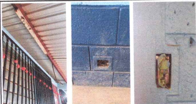
Foto 7: Reparación de sistema eléctrico.
