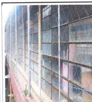
Foto 3: Sustitución de balcones.
