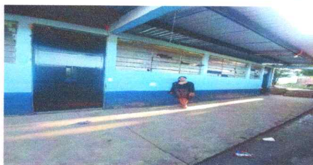
4. Sustitucion de puertas de metal.
