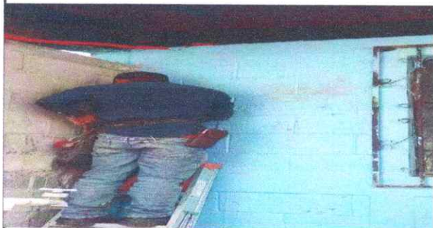
7. Reparación eléctrica, instalación de unidades luz, unidades fuerza, tableros, flipones.
