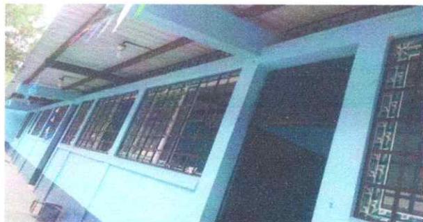
1. Sustitucion de ventana de metal mas vidrio.
