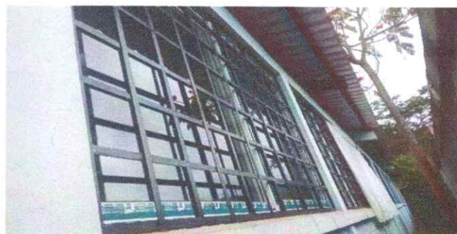
2. sustitucion de balcones de metal.
