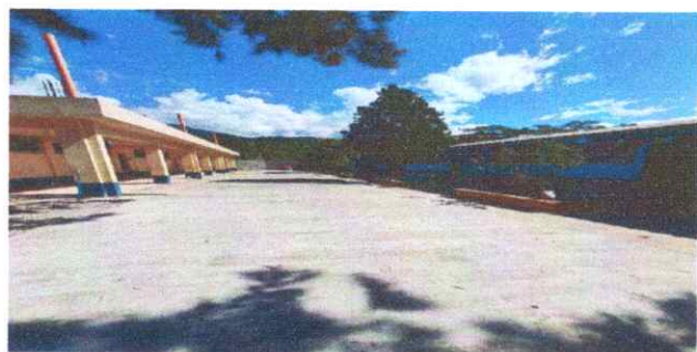
5. Reparacion de piso, torta de concreto.
