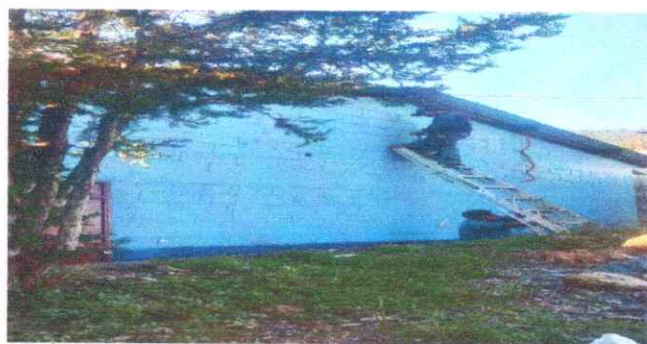
8. Acometida eléctrica y la alimentación al centro de carga.
