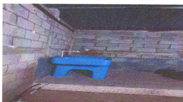
6. sustitucion de lavamanos por pila plástica de dos lavaderos.
